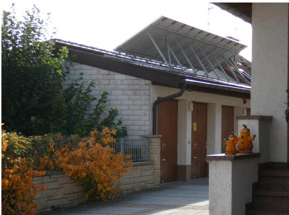
Aufgeständerte Anlage auf Schrägdach. Anlage wirkt sehr unruhig. Anlage sollte besser dachintegriert gebaut werden.
