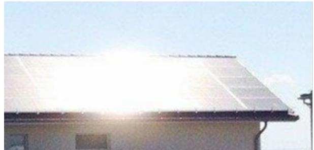
Abbildung 7: Blendwirkung von einem Schrägdach. Deutlich sichtbar ist die Bündelaufweitung, dadurch erkennbar, dass anstelle des direkten Abbilds der Sonne eine flächige Lichterscheinung sichtbar ist.
