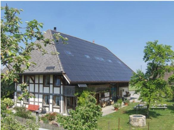
Vollflächig integrierte Photovoltaik-anlage auf einem Bauernhaus in Schüpfenried (BE). Damit die Modulfläche das gesamte Dach bedecken kann, wurden in den Randbereichen schräge Blindmodule verwendet. Auch hier ist aufgrund des Denkmalschutzes eine Baubewilligung erforderlich.
