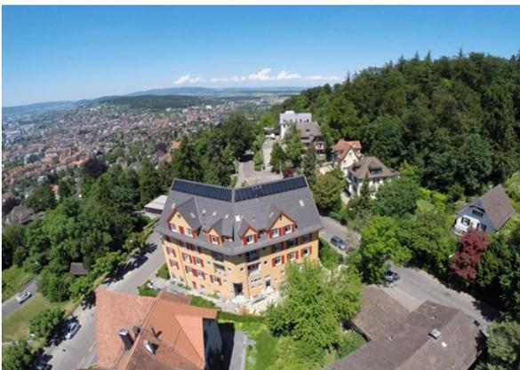
Solarthermieanlage (unverglaste Kollektoren) auf denkmalgeschütztem Justinushaus in Zürich (Baujahr 1907). Kompakte, zusammenhängende Anlage unterhalb des Firsts zur Regeneration der Erdsonden.
