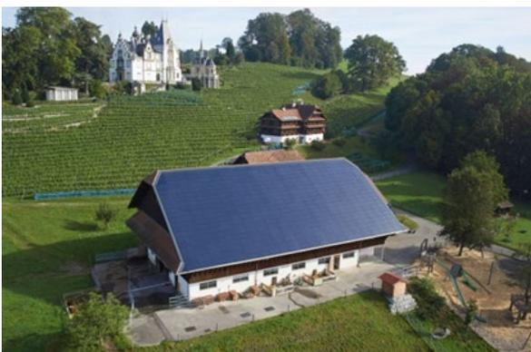
Schlossgut Meggenhorn (ISOS-Inventar mit Erhaltungsziel A), Meggen LU. Scheune mit 100 kWp / 580 m<sup>2</sup> Photovoltaikmodulen, vollflächig integriert.
