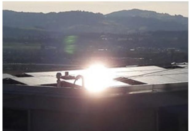
Abbildung 8: Beispiel der Blendwirkung einer PV-Anlage auf einem Flachdach. Die Solarmodule sind in diesem Fall mit leichter Neigung ungefähr nach Osten und Westen ausgerichtet.
