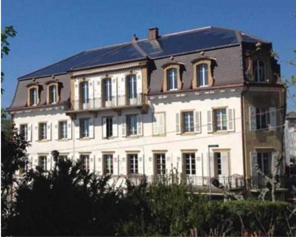
Hôtel des Associations, Neuchâtel, im Quartier du Terte, ISOS-Inventar mit Erhaltungsziel A. Dachintegrierte Photovoltaikanlage mit 28 kWp.
